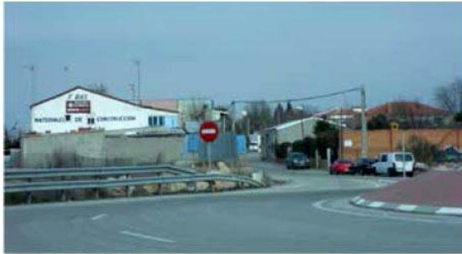
Foto 2. En esta foto se pueden observar talleres, huertos agrícolas y viviendas en el sector 3 de La Cañada. Fuente: Pilar Monreal, marzo de 2012.
