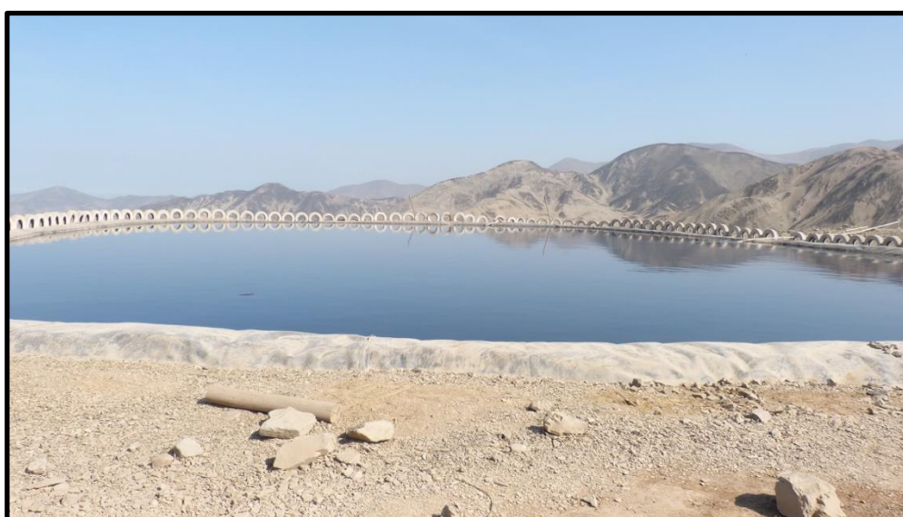
Figura 3.3: Pozo de lixiviados principal. Fuente: Archivo personal.
