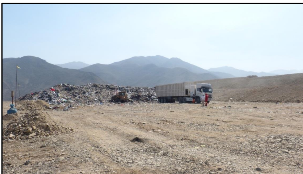
Figura 7: Celda en operación del RS Portillo Grande. Fuente: Archivo personal
