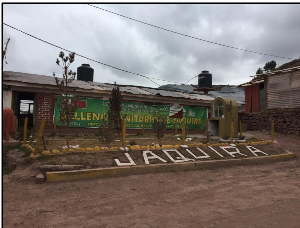
Figura 4.2: Entrada del lugar de disposición final Jaquira y sus oficinas. Fuente: Archivo personal.
