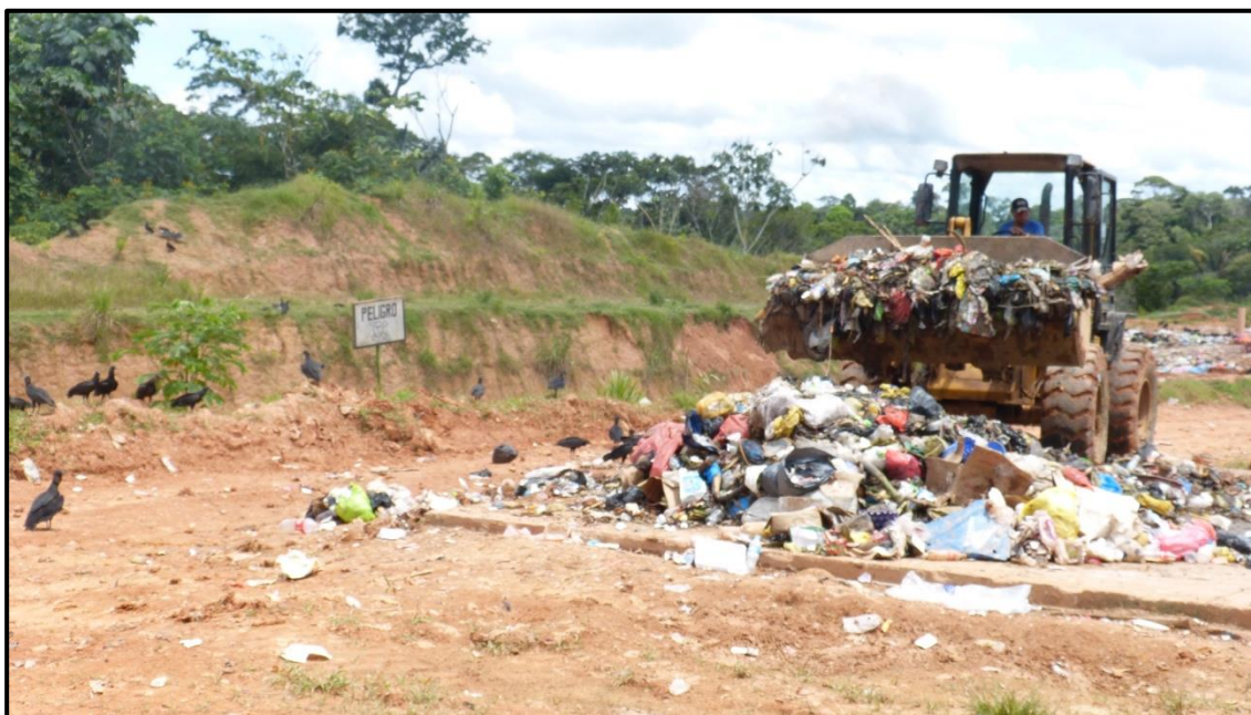
Figura 9: Cargador frontal realizando labores de relleno en el RS Nauta.
