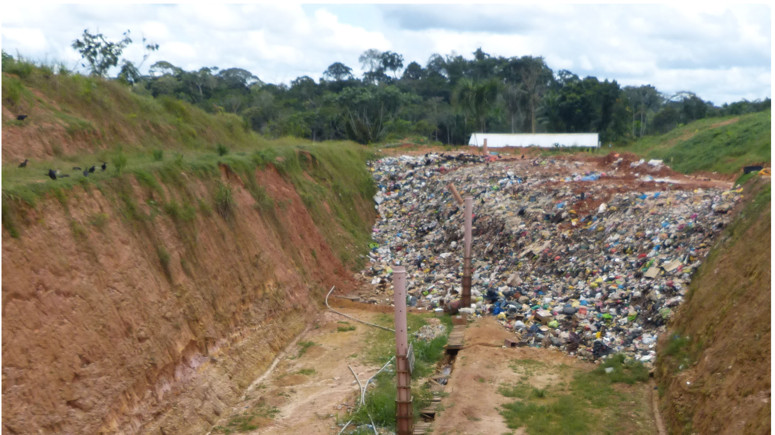
Celda abierta del relleno sanitario de Nauta. (Foto: Ian Vázquez Rowe).
